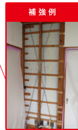
補強例 ステンレス製補強金物 壁をステンレス製補強金物で補強しました。
