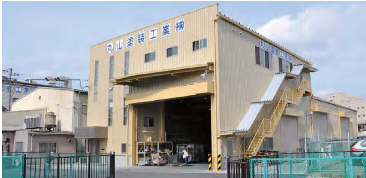
8基の大型乾燥炉が稼働する本社
