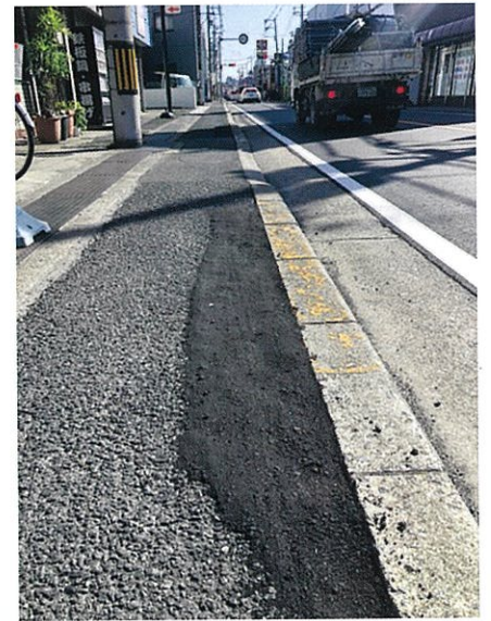
補修した歩道
