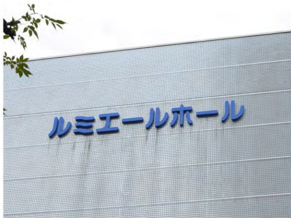
外壁サイン現況色
