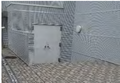
南側小ホール入口
