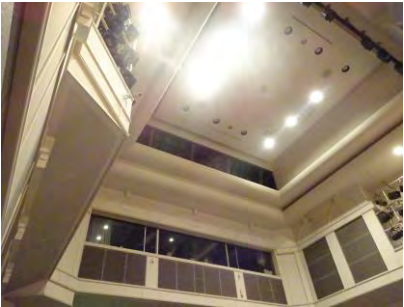
小ホール 天井耐震改修
