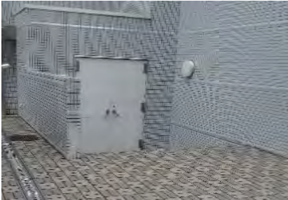
南側小ホール入口
