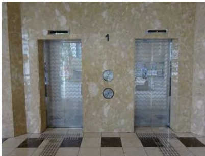
エレベーター耐震改修
