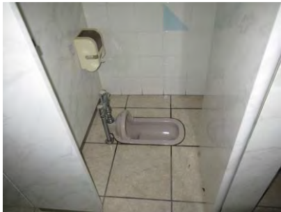
トイレ大便器 洋式便器に改修
