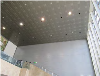
エントランスホール 天井耐震改修
