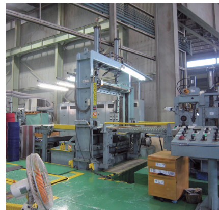
スリッターのライン
