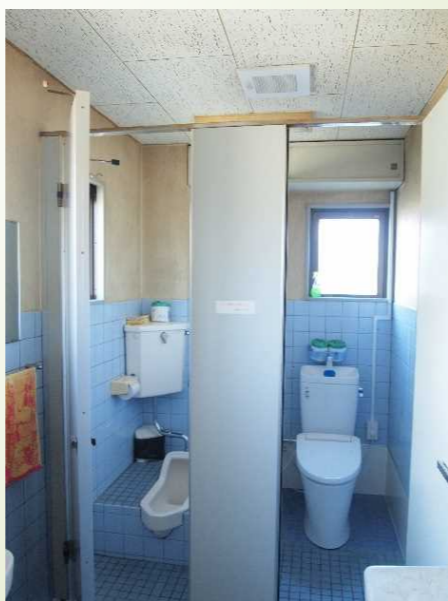
市の補助事業を活用し工場内に2箇所の女性専用トイレを整備（洋式化）
