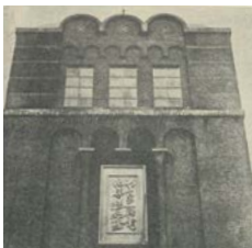
古川橋変電所 (「曾水一条電浪華万燭春」 福沢 桃介 書) (資料)門真町史
