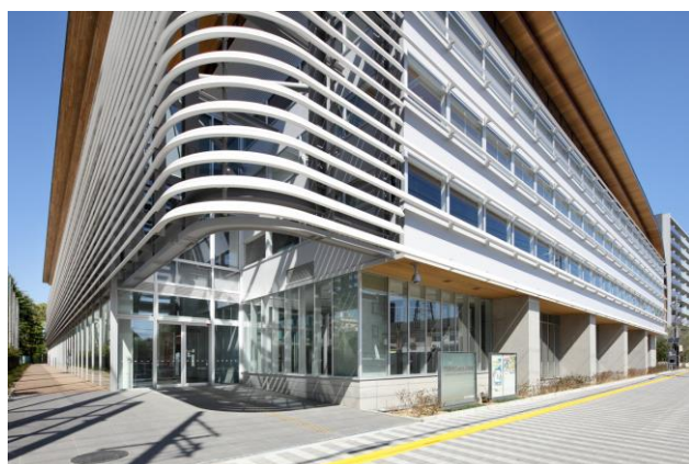
図6-4 門真市立総合体育館の太陽光発電設備（一体型ルーバー）
