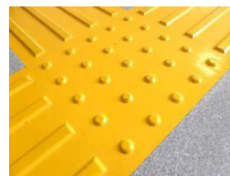
■ 警告ブロック
