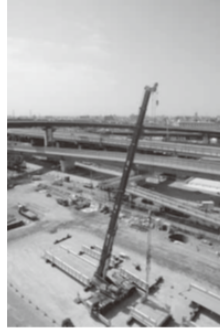
(平成21(2009)年9月撮影) 第二京阪道路門真JCTの工事風景
