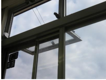
放課後児童クラブ（門真小） 窓・扉(外部)：D 排煙オペレーターの破損
