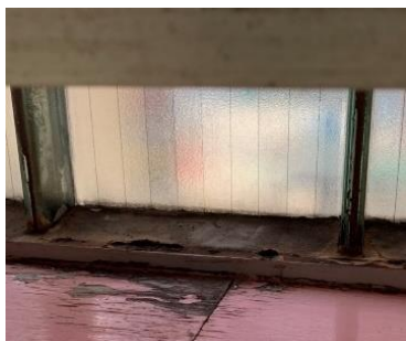
大和田幼稚園 窓・扉（外部）：D 玄関扉の錆／パッキンの劣化
