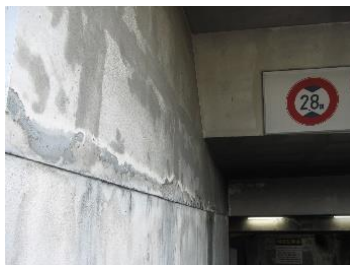
門真プラザ地下駐車場 外壁：D
