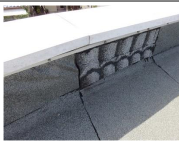
ルミールホール地下駐車場 外壁：E 漏水の疑い
