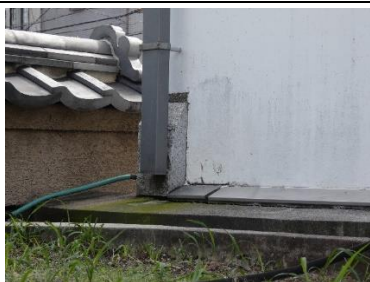
ルミールホール地下駐車場 外壁：E 漏水の疑い
