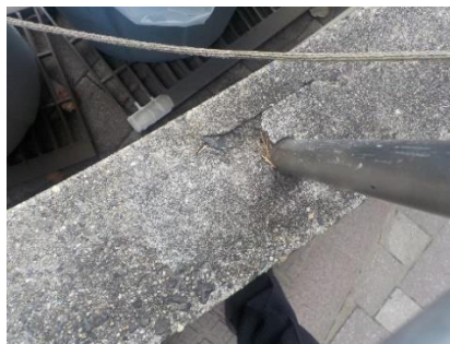
門真市立テニスコート・ 青少年運動広場／管理棟 外部雑：C 手すり根本ひび
