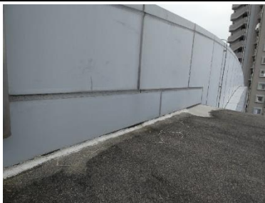
ルミールホール 屋根・屋上：C
