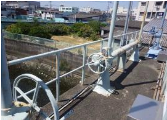
写真一 北島第2樋門
