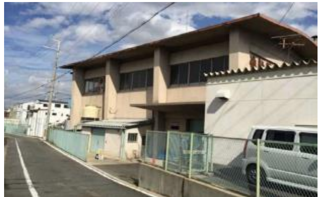
写真二 下八箇荘排水機場
