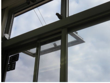
放課後児童クラブ（門真小） 窓・扉(外部)：D 排煙オペレーターの破損
