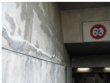
門真プラザ地下駐車場 外壁：D
