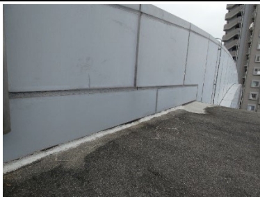
ルミールホール 屋根・屋上：C
