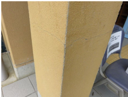
放課後児童クラブ（砂子小） 外壁：C 柱ひび
