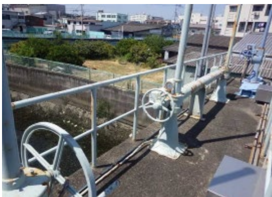
写真一 北島第2 樋門
