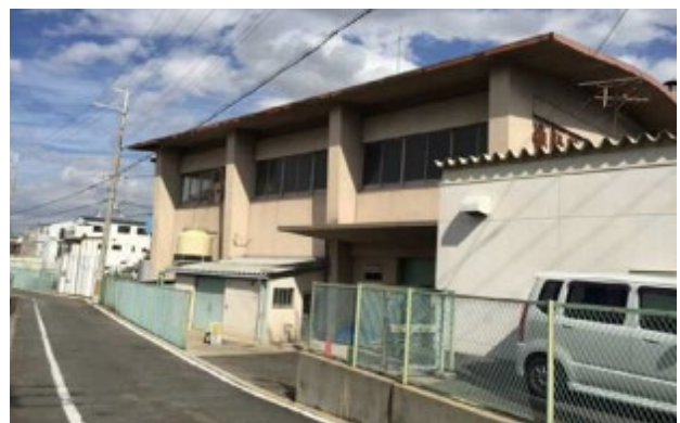
写真二 下八箇荘排水機場
