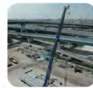
第二京阪道路門真JCTの工事風景(平成21(2009)年9月撮影)
