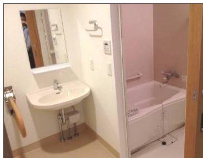
■洗面室・浴室
