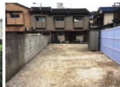
完成した防災空地
