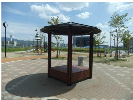
防災シェルター（北島東町公園）
