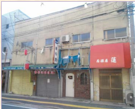
【従前の老朽木造建築物】
