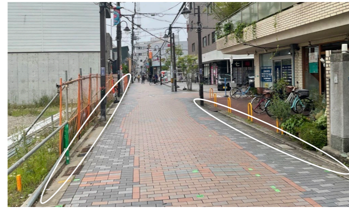
インターロッキングブロック舗装
