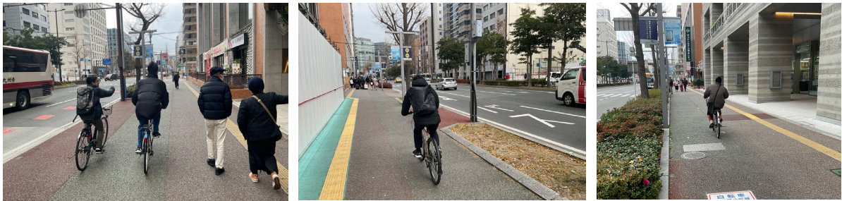
舗装の切り替えによる交通誘導（住吉通り（福岡市））
