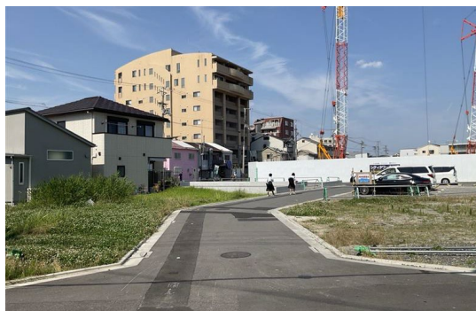
店舗が軒を連ねていたが、一時的に空き地となっている
