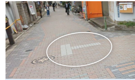
道路標示をインターロッキングブロック舗装のデザインに合わせて表現
