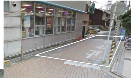
商店街への接続箇所は通りと同じくインターロッキングブロックで舗装されている
