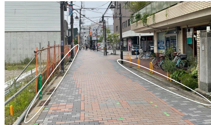
インターロッキングブロック舗装
