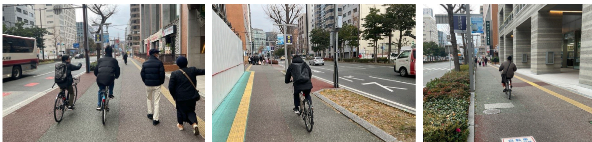
舗装の切り替えによる交通誘導 (住吉通り (福岡市))
