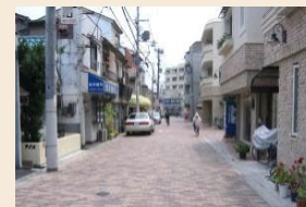
拡幅された道路（幅員6.0m）
