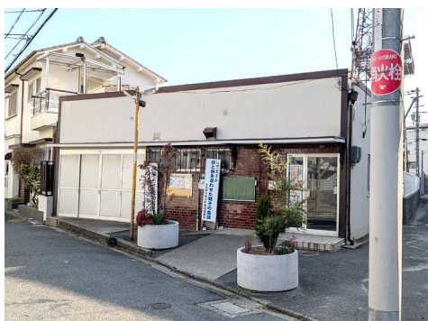
公園に隣接する自治会館
