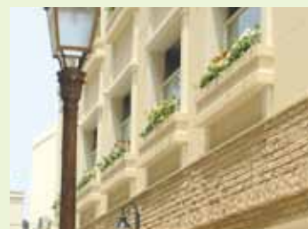
開口部（プランター設置スペース）
