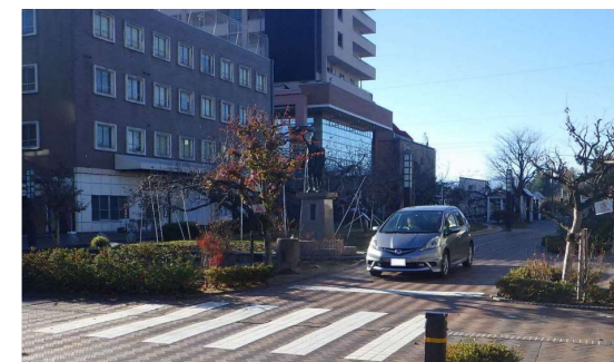
歩道と同じ舗装として減速を促す車道
