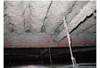
◎吹付けアスベスト施工事例
