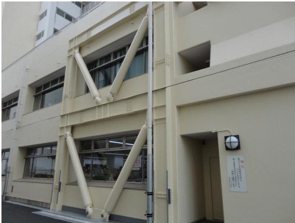
平成 27 年度に実施した耐震改修事例
