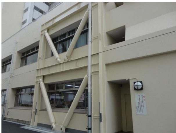
平成 27 年度に実施した耐震改修事例
