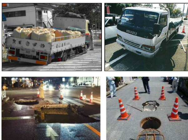
下水道管路に起因した道路の陥没事故
