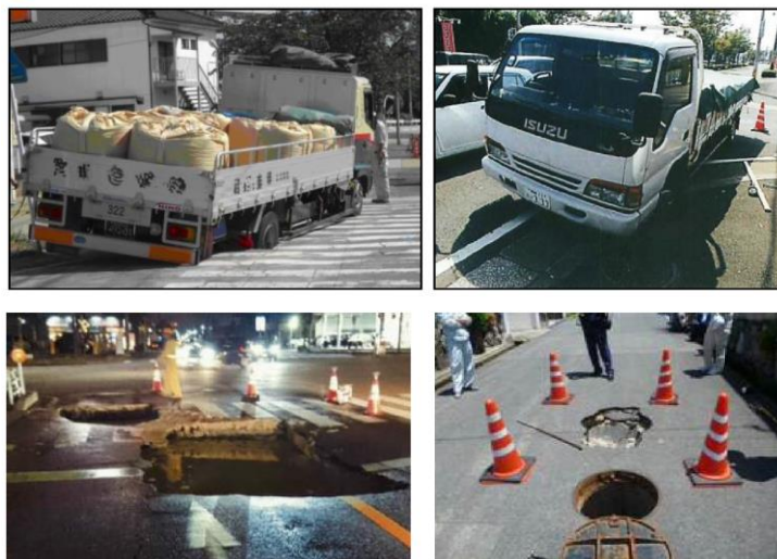
下水道管路に起因した道路の陥没事故
