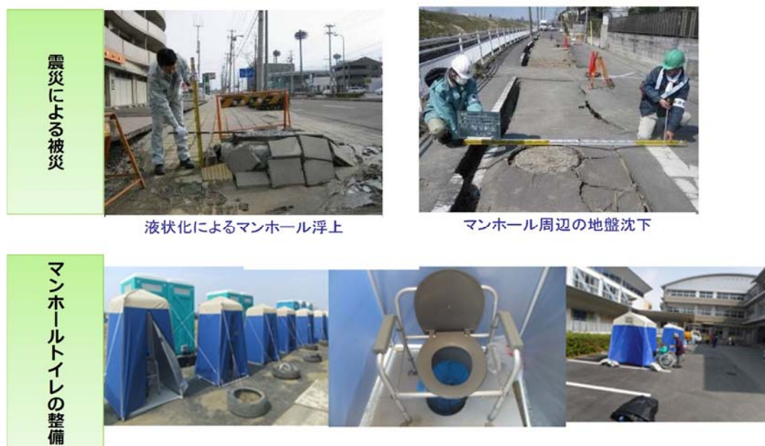
図 1-3 震災による被災例及びマンホールトイレの事例
