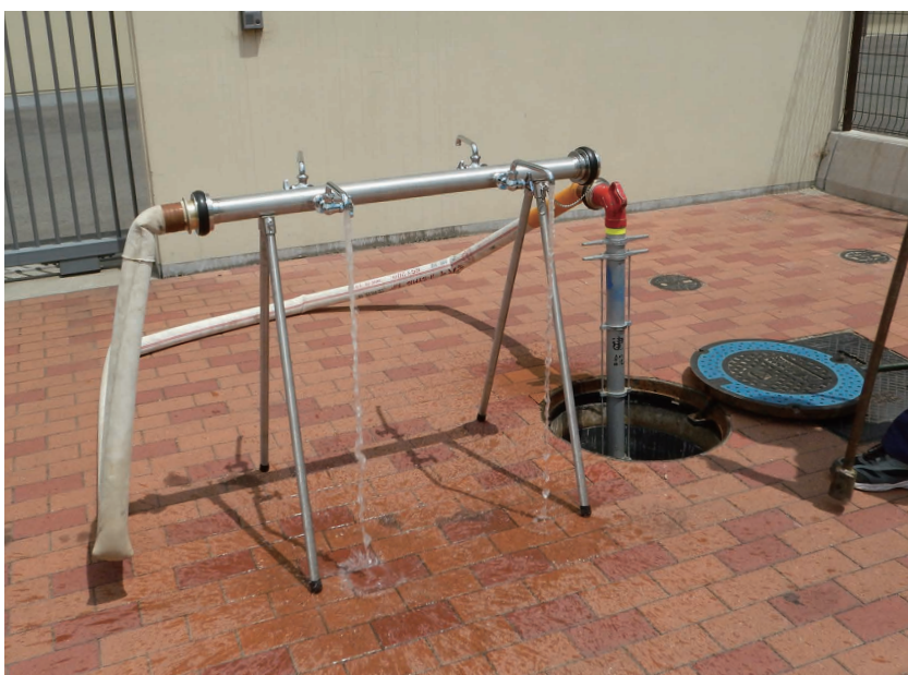
●応急給水栓を使用した給水状況
