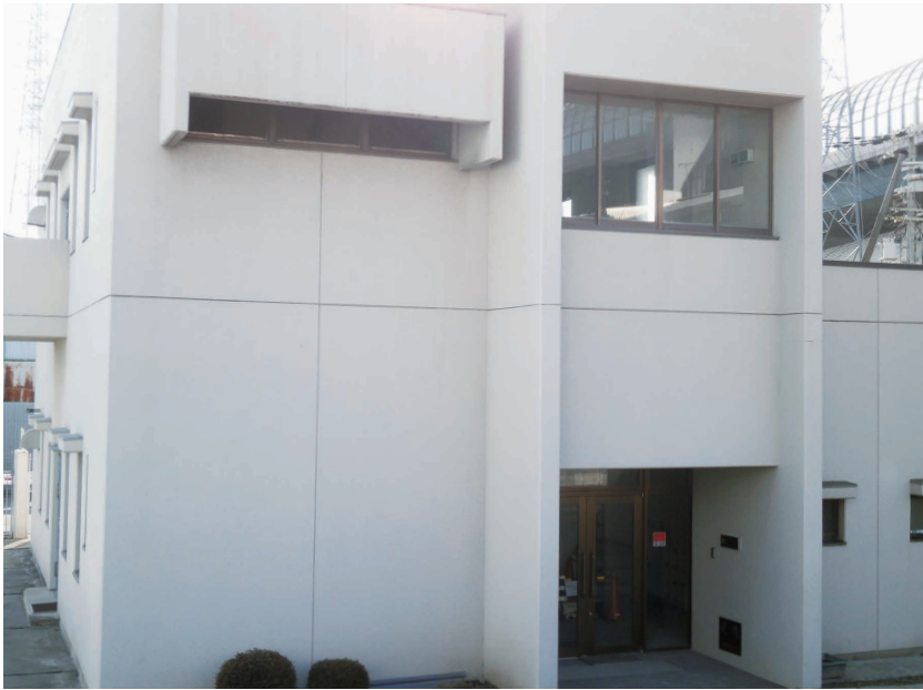
●上馬伏配水場ポンプ棟
