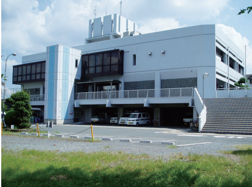
● 泉町浄水場集中管理棟
