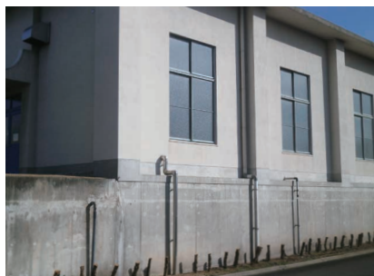
●泉町浄水場第2ポンプ室
