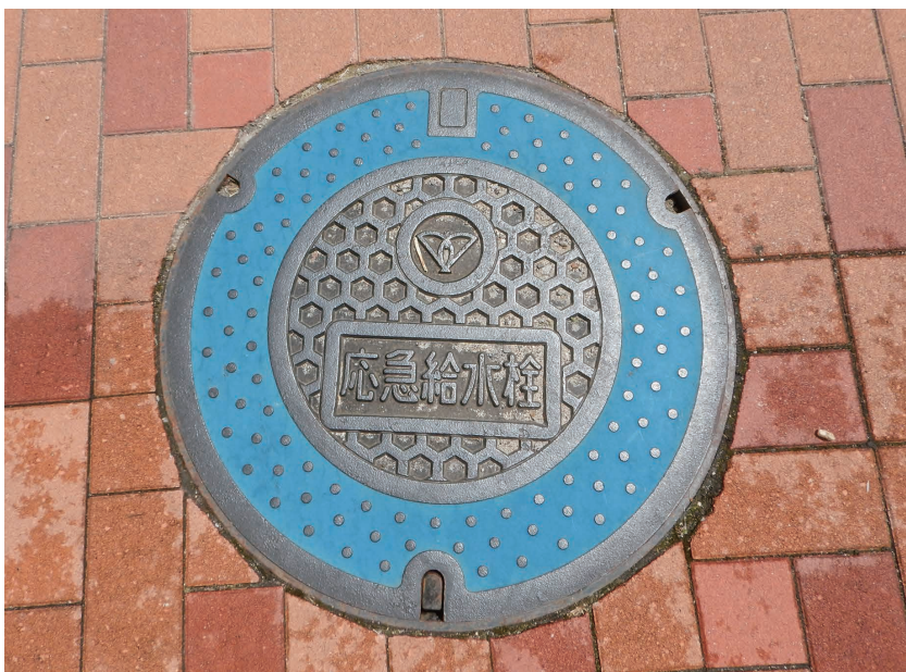
●避難所へ応急給水栓を設置
