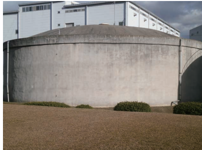
● 上馬伏配水場3号配水池
