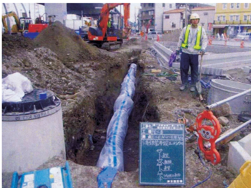
●第二京阪道路工事に伴う水道管布設工事
