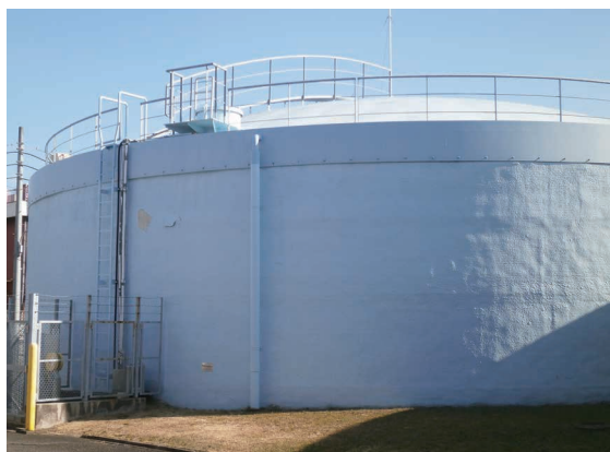
●泉町浄水場2号配水池
