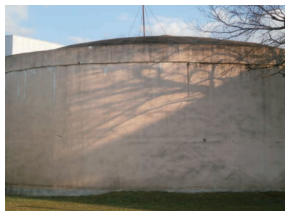
●泉町浄水場3号配水池
