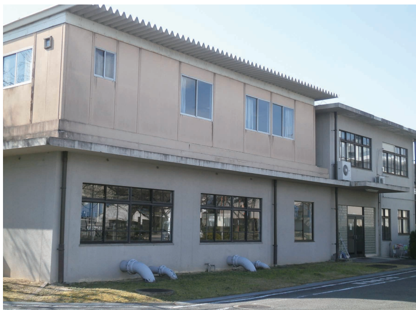
●泉町浄水場第1ポンプ室
