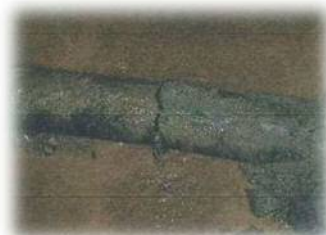
管破損状況
