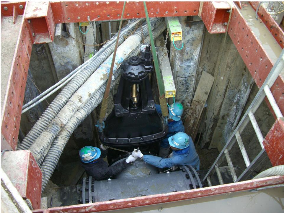
(上馬伏配水場場内配管工事 φ600mm 仕切弁取付)
