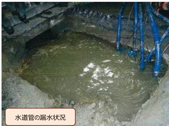
写真-1 門真市内で実際に起こった漏水状況
