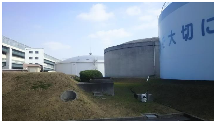
上馬伏配水場 PC 配水池
