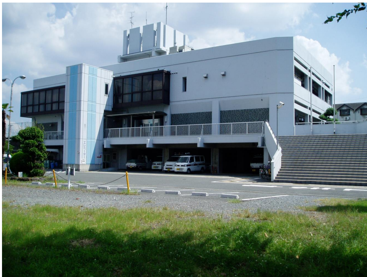
泉町浄水場 管理棟
