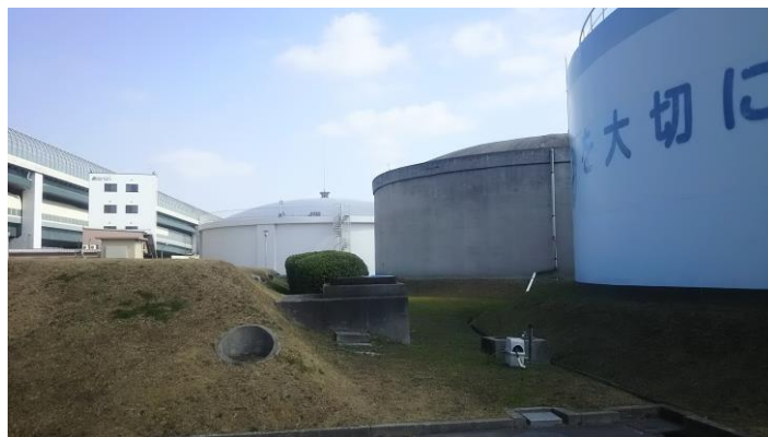
上馬伏配水場 PC 配水池
