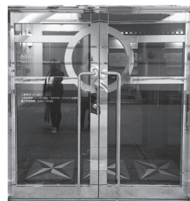
USJで使われているステンレス鏡面仕上げのドア
