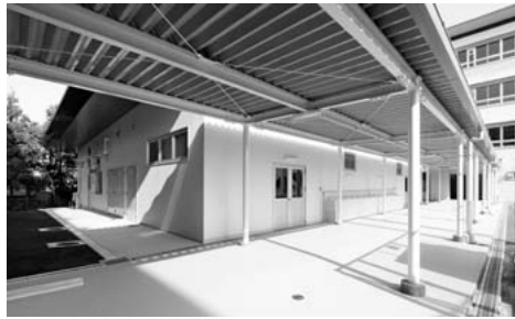
建て替え後きれいになった給食棟
