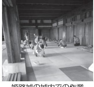
姫路城の城内での作業
