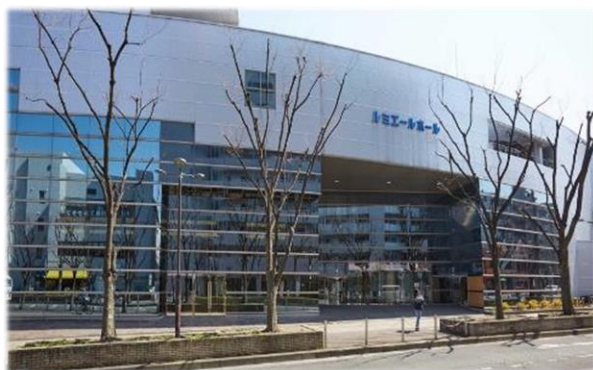
ルミエールホール(門真市民文化会館)
