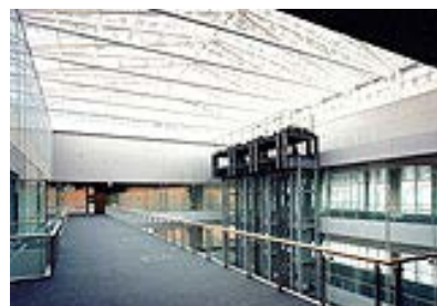
ガラス屋根と一体化させた透過型太陽光発電システム （いわて県民情報交流センター）
