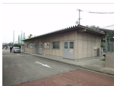
陶芸木工室の外観
