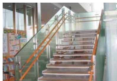
2段手すり（岡山県立図書館）
