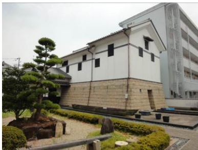
増築部分の建物
