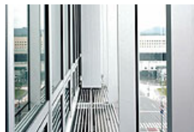
ダブルスキン（二重のガラス外壁） （いわて県民情報交流センター）
