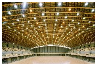
杉無垢材を使用した屋根構造 （所沢市民体育館）
