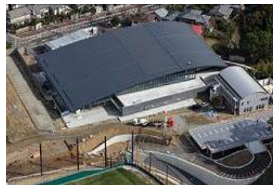
屋上での太陽光発電
