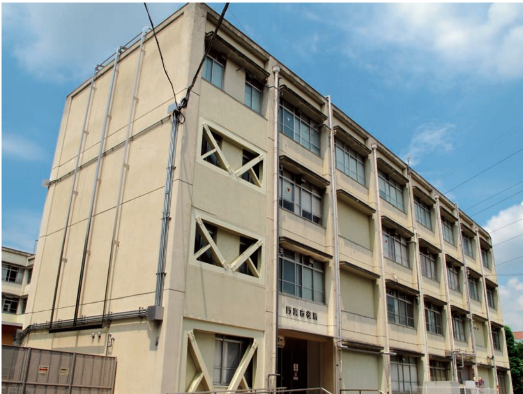
庁舎本館（平成25年5月7日～）
