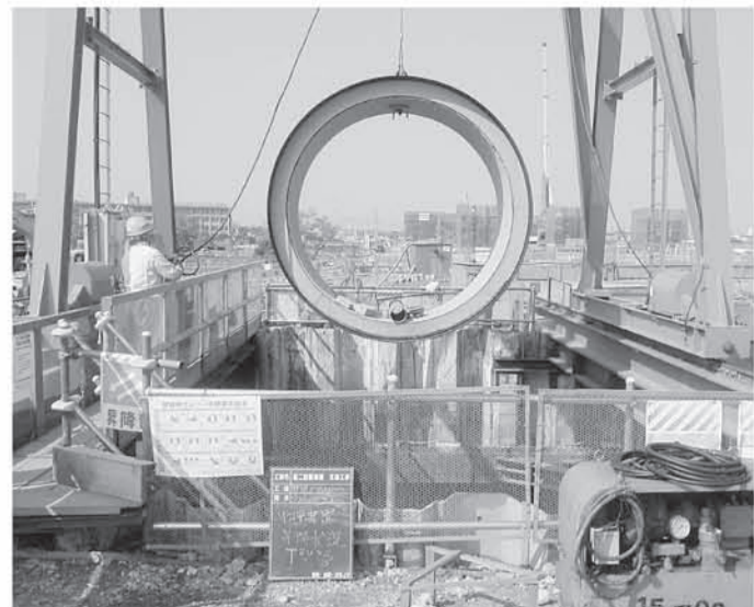
第2京阪道路内に整備中の公共下水道
