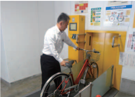
相模原市の機械式地下駐輪場
