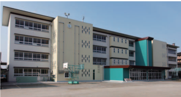
第1期工事が終了した第五中学校
