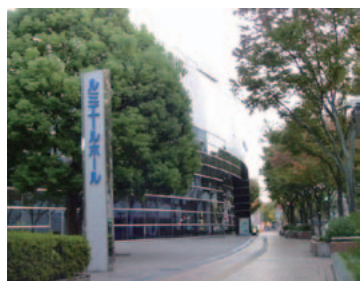
大規模改修予定のルミエールホール
