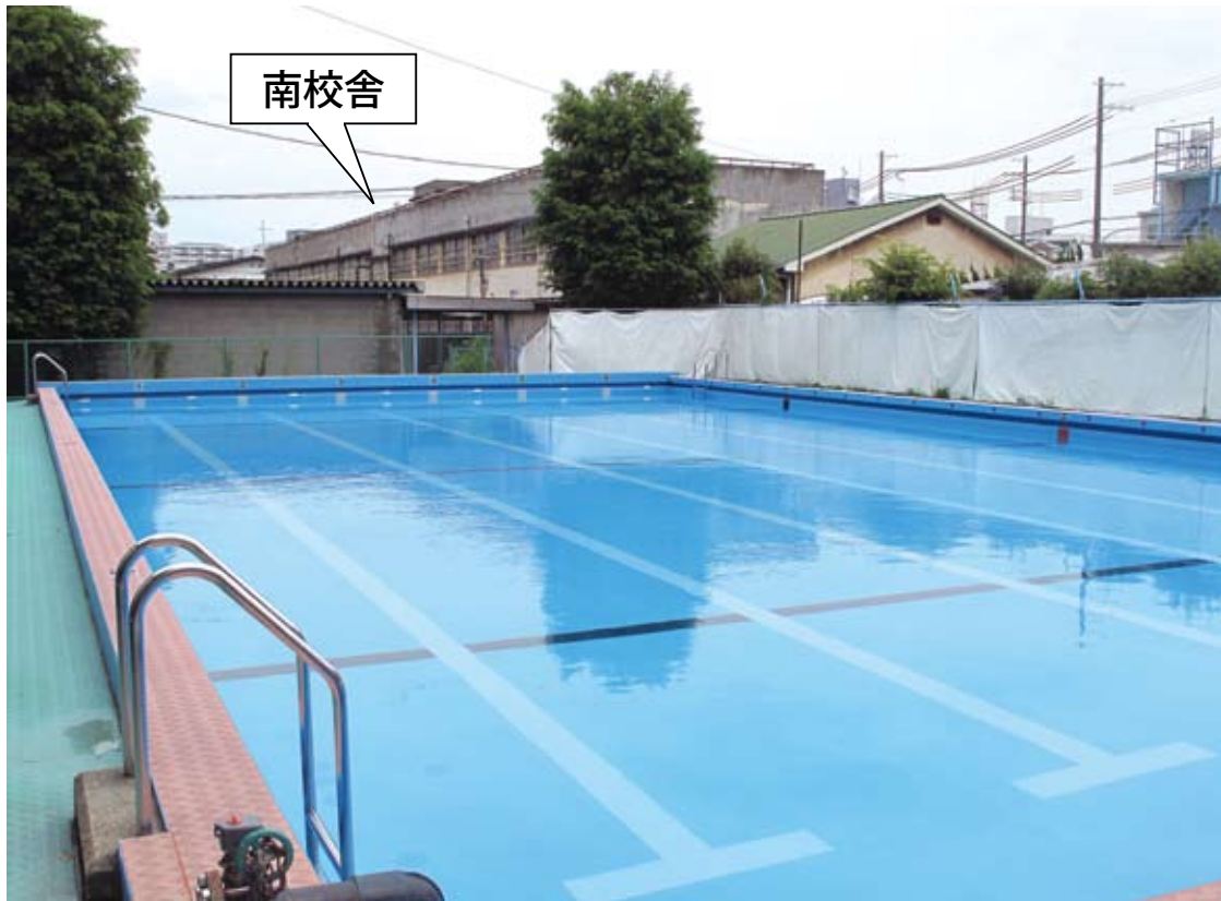
建替予定の門真小学校プールと撤去予定の南校舎
