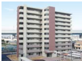
建てかえが進む府営門真住宅
