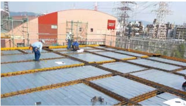
建設工事中の総合体育館
